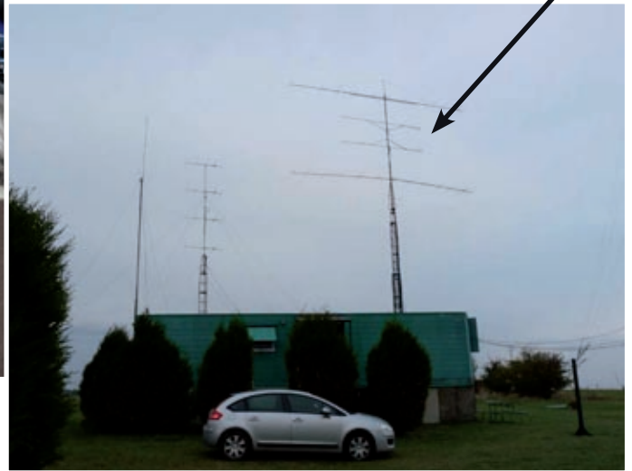
Les 2 x 21 éléments TONNA entre les deux yagis 144 MHz
